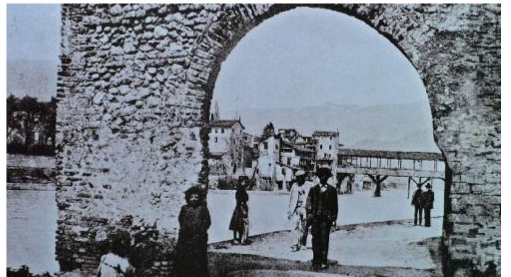
La porta costruita nel Cinquecento in riva al fiume: fu abbattuta verso la fine dell'Ottocento
