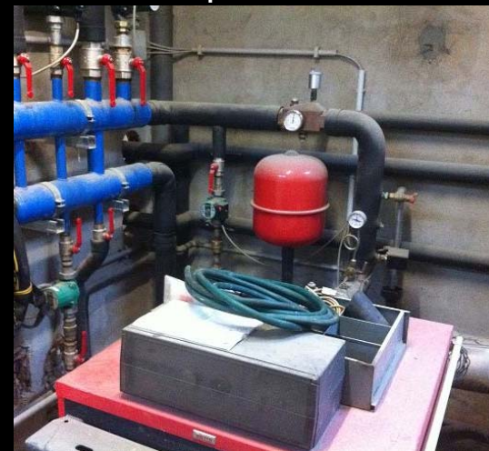
Particolare centrale termica impianti sportivi Q.re Pre'
