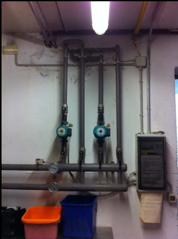
Particolare centrale termica impianto sportivo S. Croce
